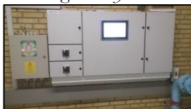
Den nye styretavle
