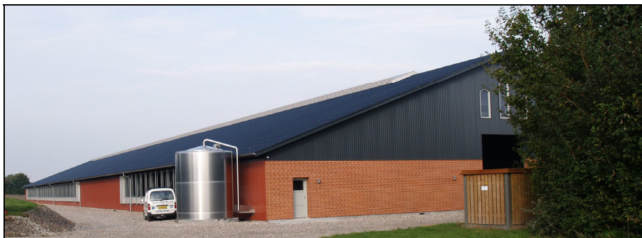
Den nye store stald ved Tvingbro
